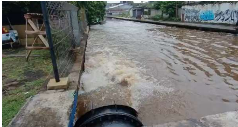
Gambar 3. 15 Operasional Pompa dan Pintu Air Saat Curah Hujan Meningkat
