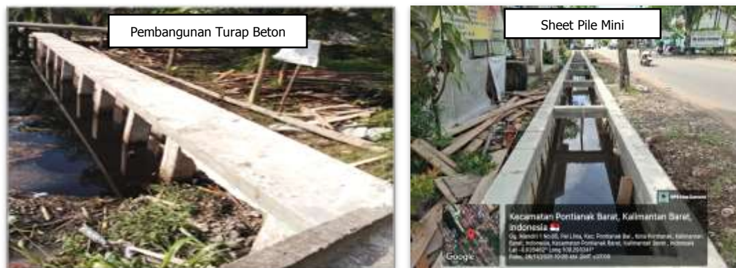
Gambar 3. 16 Pembangunan Turap dan Sheet Pile Mini Untuk Penanganan Jangka Panjang
