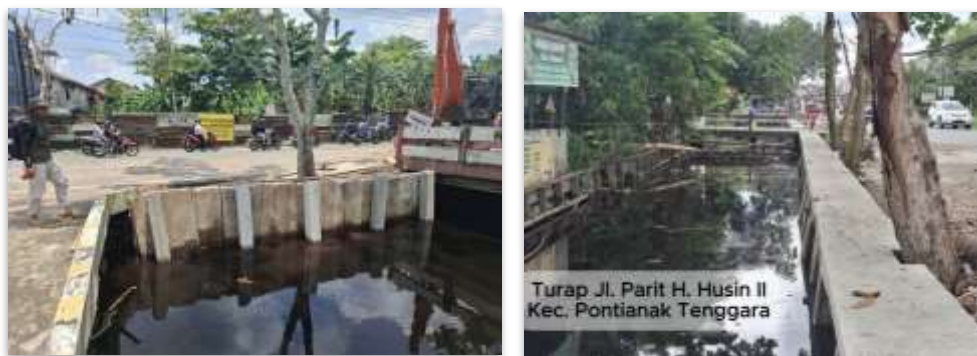
Gambar 3. 6 Kegiatan Pembangunan Turap
