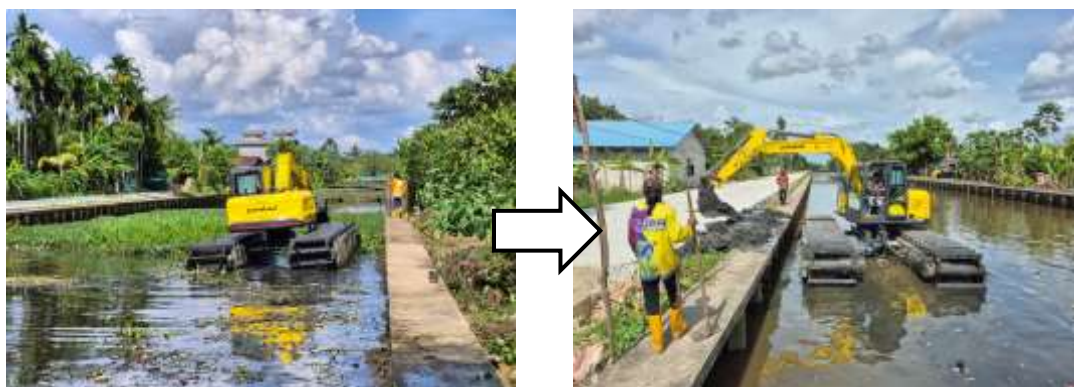
Gambar 3. 13 Kondisi Saluran/Parit Sebelum Normalisasi dan Setelah Normalisasi
